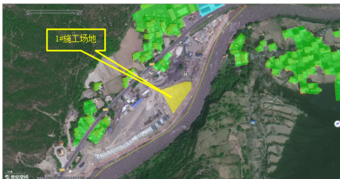
图 4-1 临时施工场地外环境情况 (1#)
