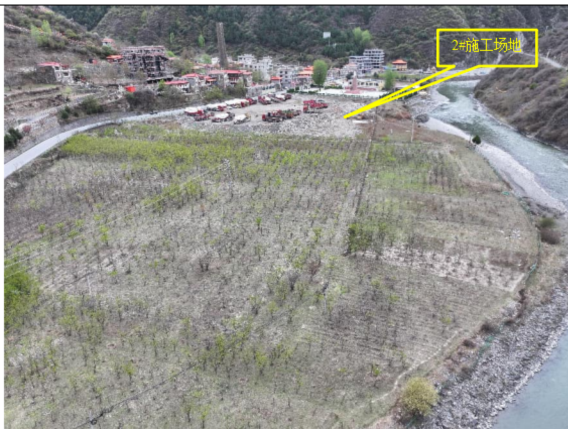
图 4-4 临时施工场地外环境情况 (2#)
